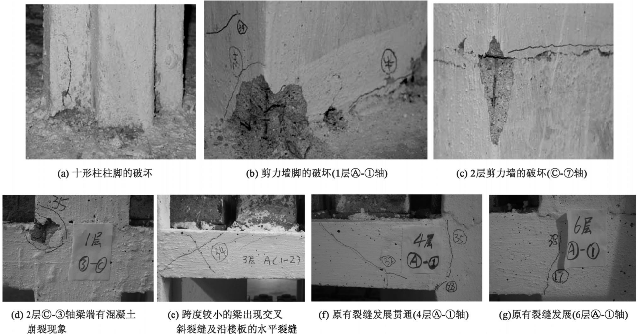
图 7 8 度强罕遇烈度双向输入后的裂缝 (标示为③ ~ ⑧)
